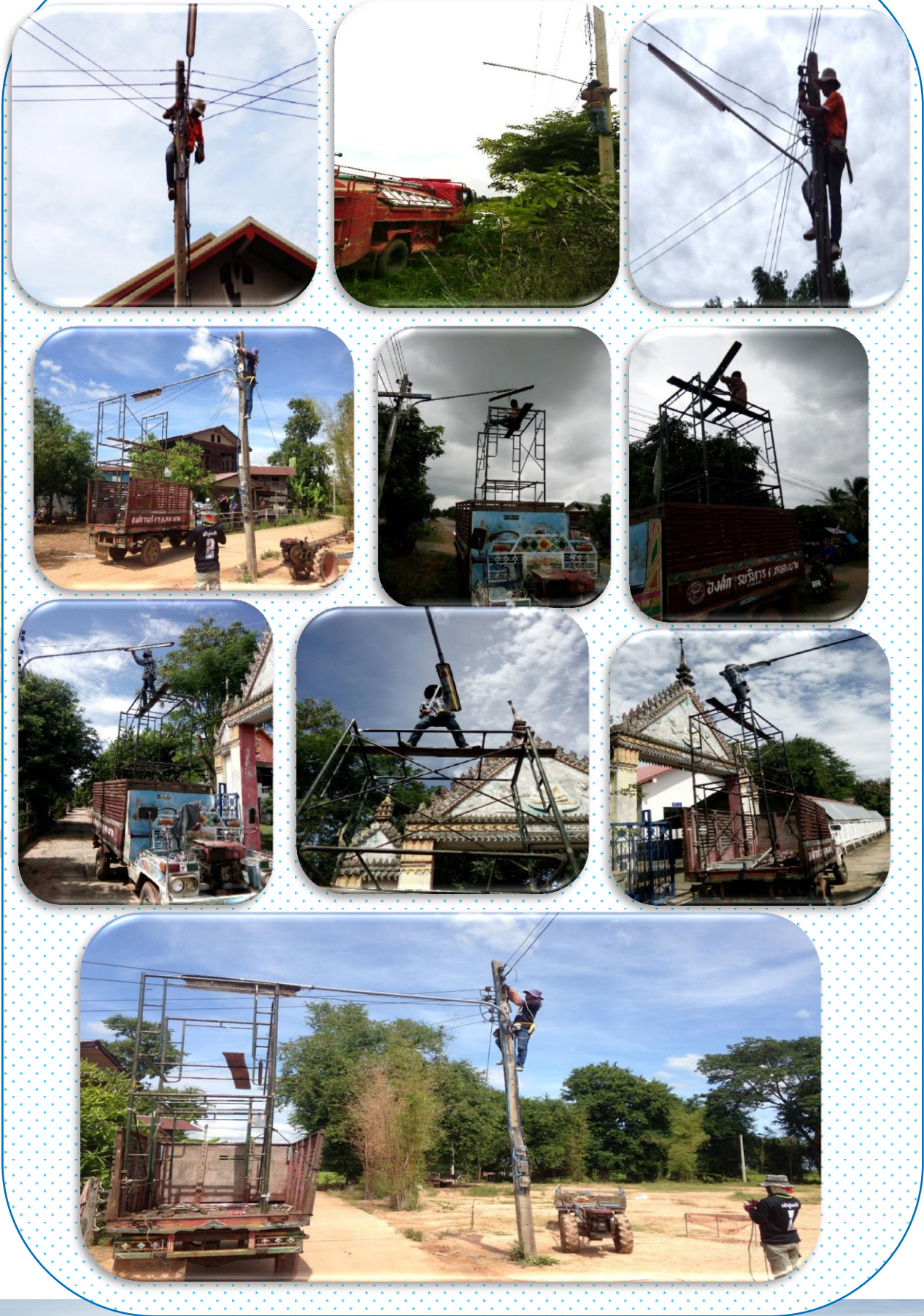
การซ่อมบำรุงไฟฟ้าสาธารณะ
